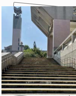
入口2 【正門斜坡長樓梯】
